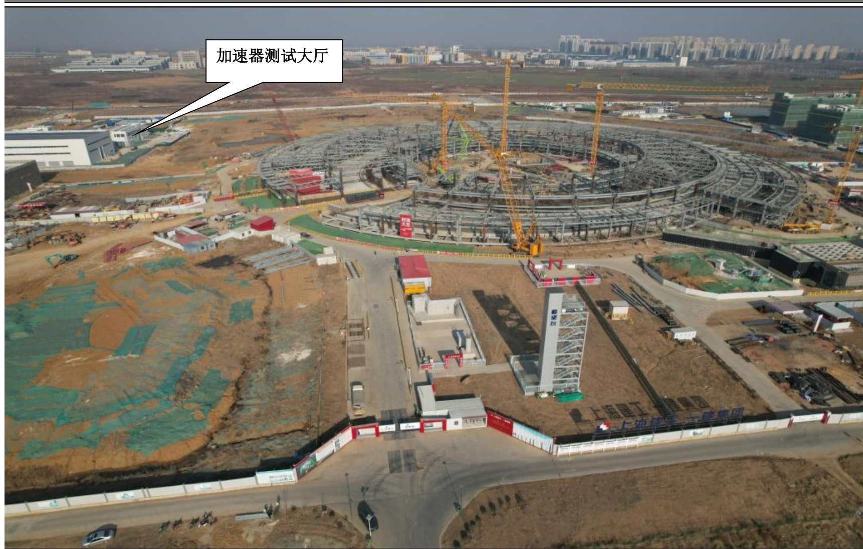
图 1.2-3 现场航拍照片
