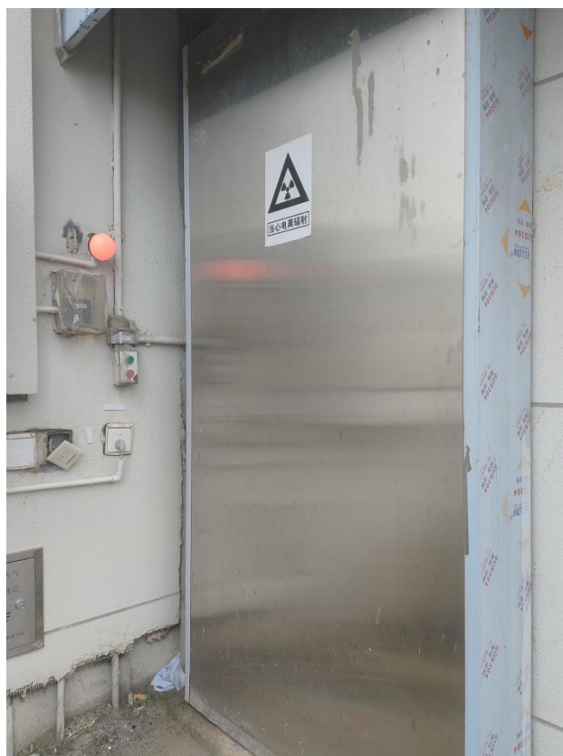
图 A.5.1-2 警示标志、声光报警和工作状态指示灯
