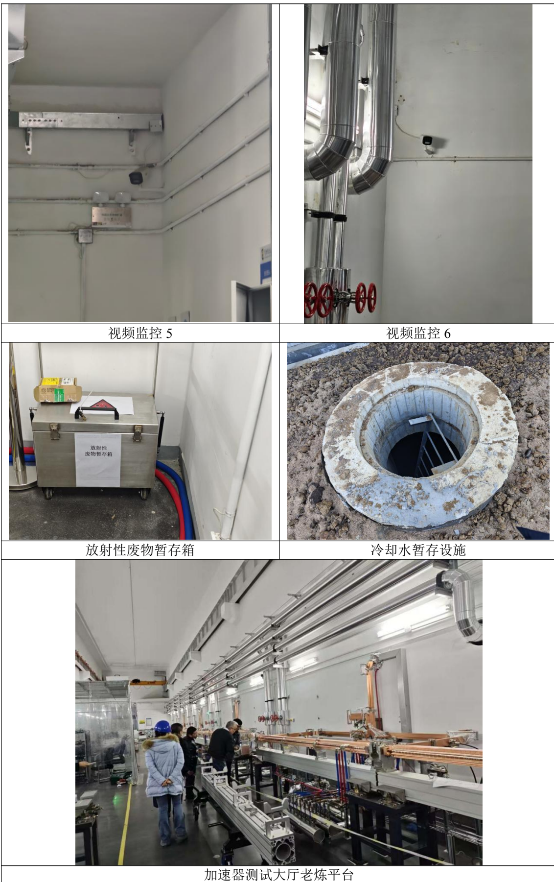
图 A.5.1-9 验收现场勘查照片
